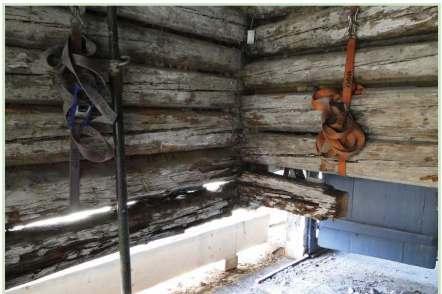
Uchytenie vrchných trávov konštrukcie
