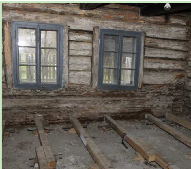
Očistená konštrukcia v zadnej izbe
